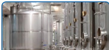
Tankreinigung tank cleaning
